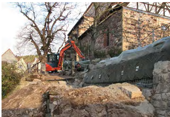
... um Baufreiheit für die aufwendige Hangsicherung zu schaffen (Bauzustand am 10.03.2017)
