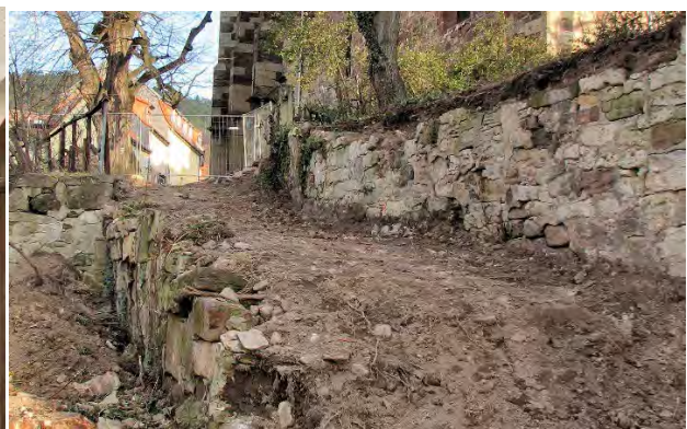
Die alte Treppe wurde vollständig entfernt, (Bauzustand am 26.02.2017)
