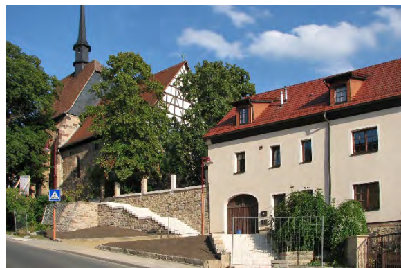
Ende Juli 2017 ist die Reko im Wesentlichen abgeschlossen. Es fehlen lediglich das Treppengeländer und der Zaun auf der Mauer
