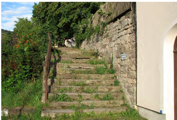
Zustand der Treppe und der Stützmauer vor der Renovierung (August 2016)
