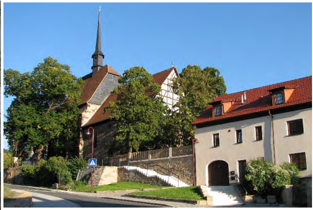
... und die Außenanlagen fertiggestellt worden waren...
