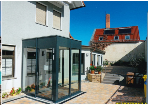
Die fertiggestellte Arztpraxis Susanne-Bohl-Str. 16 im August 2017; Foto: Anneliese Tilgner
