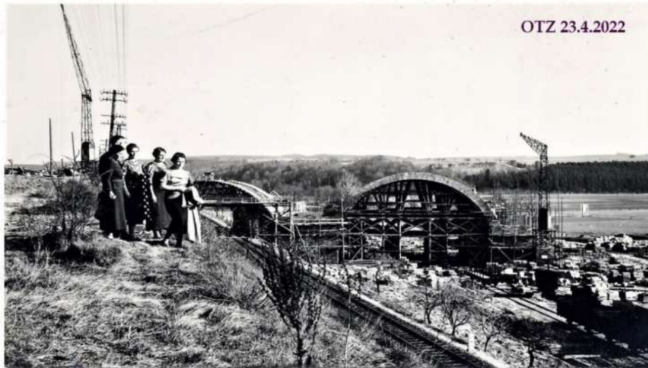
Der Bau dieses gewaltigen Bauwerkes mit der Inbetriebnahme der Teilstrecke Meerane – Jena (Ausfahrt Lobeda) im Dezember 1937 und der anschließende Bau der fast einen Kilometer langen Saaletalbrücke (Bild) waren architektonische Höchstleistungen für die damalige Zeit. Im August 1939 konnte das nächste Teilstück bis Weimar in Betrieb genommen werden. FOTO: ARBEITSKREIS ORTSGESCHICHTE
