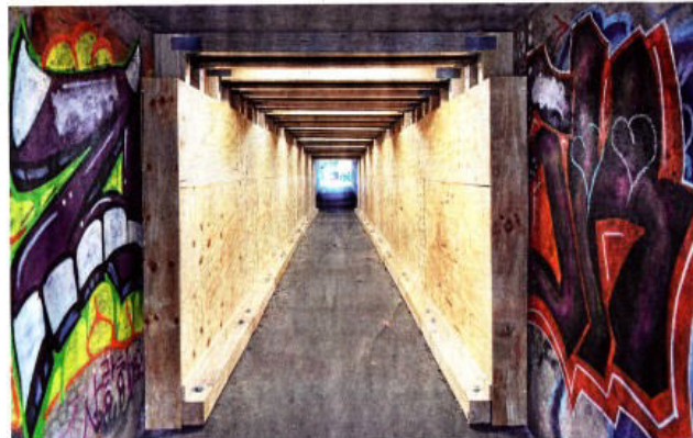
Könnte fast als Jenaer Wunder durchgehen: In den Goldbergstunnel wurde ein weiterer Tunnel gebaut.
