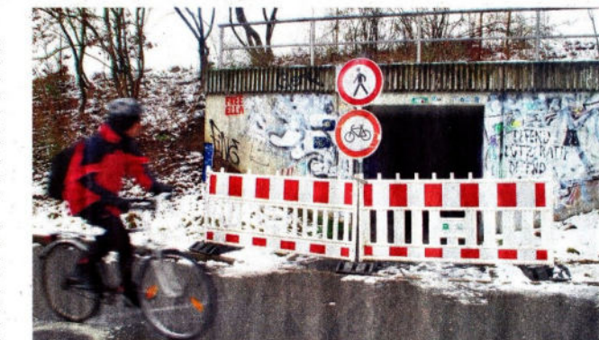
Ein Radfahrer blickt von Westen in die Mündung des Goldbergtunnels, der seit Montag für Radfahrer und Fußgänger wegen Bauarbeiten gesperrt ist.
