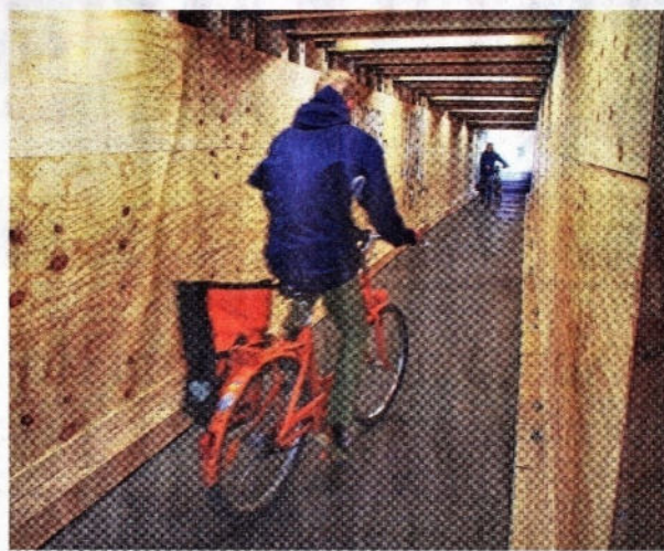
Könnte eng werden: Zwei Radfahrer begegnen sich im Goldbergstunnel. Hinter den Holzwänden befinden sich Stahlträger, mit denen die Tragfähigkeit der Decke verbessert wird.
