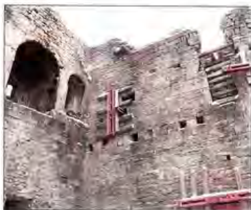
Der Palas der Lobdeburg. Hier sollen 2014 Sanierungsarbeiten erfolgen. Fotos (2): Michael Groß
