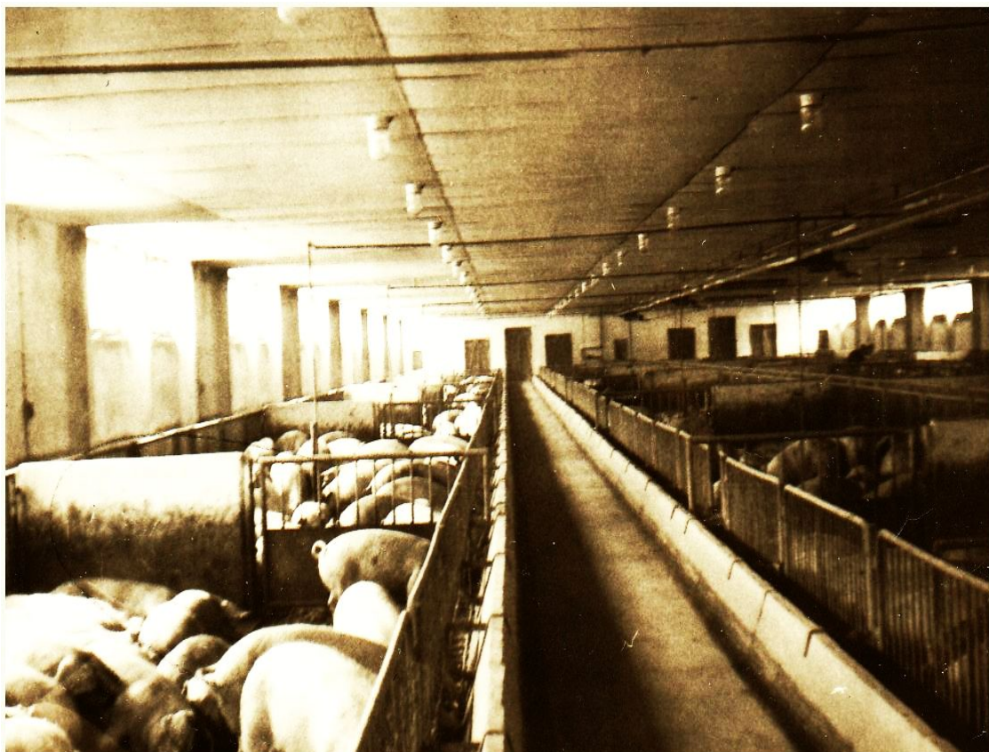
Abb. 6 Mastanlage – innen- mit Mittelgang (Privatfoto Werner Wagner, Lobeda- Altstadt)
