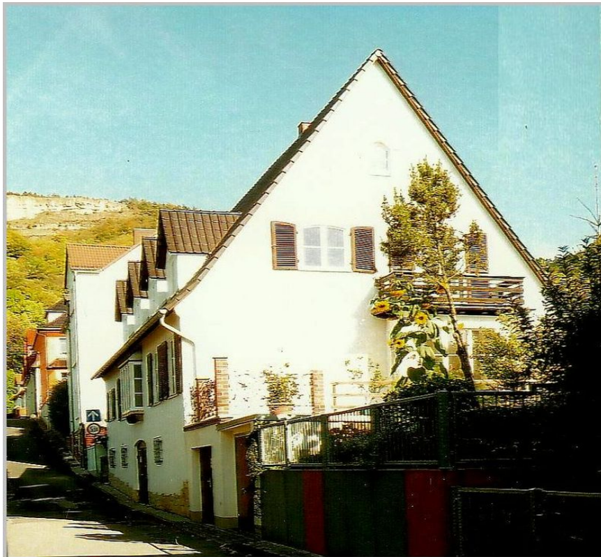
Abb. 21: Wohn- und Geschäftshaus Dr. Griefahn, Klara- Griefahn- Straße 14, Foto: Frau Dr. Tilgner, Jahr 2010
