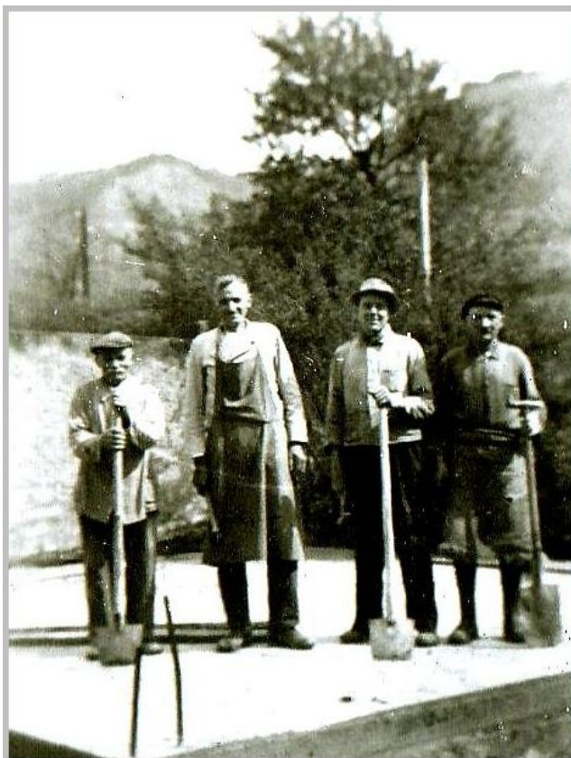
Abb. 43: B. Göbner und Co, auf der Baustelle Privatfotos Familie Göbner, Lobeda
